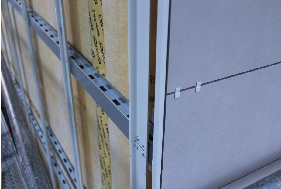
HT-106 R asennettu vakaan, maaltut kiinnitysorret pystyyn. Kulmalista kiinnitetty tuuletusorren päähän
