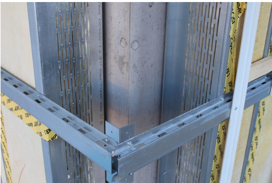
Keraaminen julkisivu, laattakoko 300x600, rakennetaan lämpörangan päälle.
