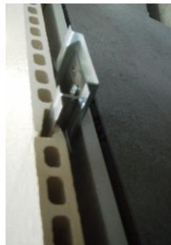
Urapontti piilokiinnitys
